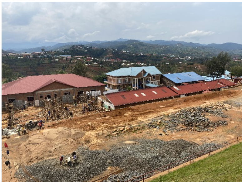
Byggeplass på sykehuset
