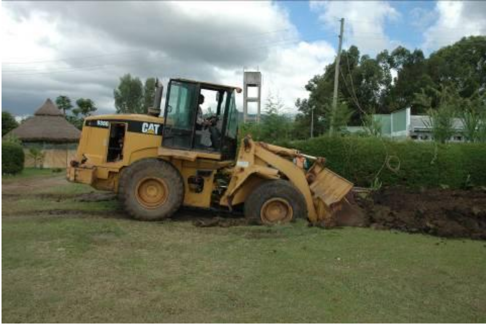
Først graver hjullasteren et hull i bakken, skolen kan vi skimte i bakgrunnen...
